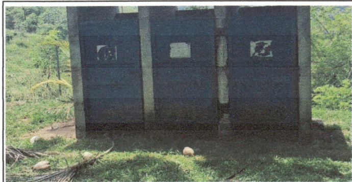
Foto 5: se observa en la fotografía el deterioro de la puerta del baño de la escuela.
