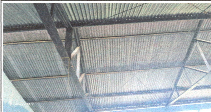
Foto 6: Se observa en la fotografía el deterioro de la costanera de la escuela.
